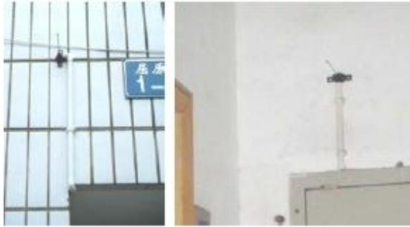
图6-3馈线使用PVC管走线
