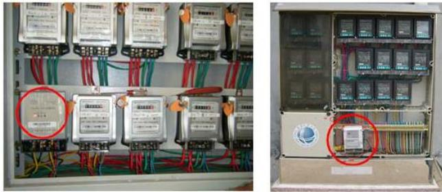
图6-4采集器安装在电表箱内
