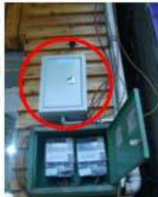
图6-5采集器安装在电表箱外
